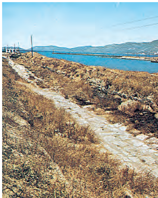
Ο δίολκος. Ο Περίαςδρος συνέλαβε την ιδέα να κόψει τον Ισθμό. Το έργο δεν πραγματοποιήθηκε λόγω ανυπέρβλητων εμποδίων. Ο ίδιος όμως φρόντισε να κατασκευάσει τον δίολκο, έναν λιθόστρωτο δρόμο, πάνω στον οποίο σύρονταν τα πλοία, προκειμένου να αποφευχθεί ο περίπλους της Πελοποννήσου. Τι είναι ισθμός και τι διώρυγα;
